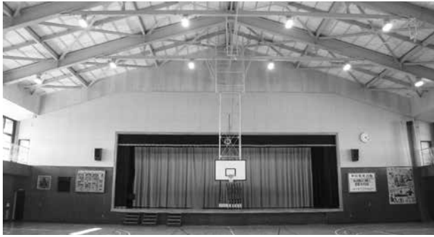
吊天井改修 (蔵波中 H27 実施)
